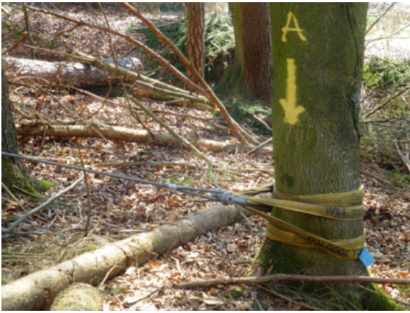
Gut sichern: Das Tragseil muss an zwei Ankerbäumen fixiert werden.
